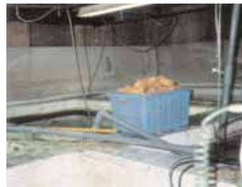
Wasserumwälzung im Tank eines Fischhändlers
