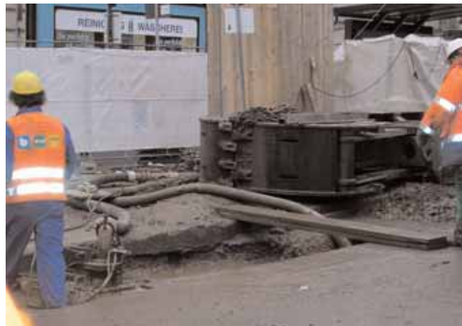
Schlitzwand mit Druckleitungen
